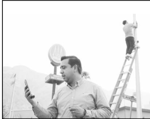
El alcalde Jesús Nava supervisó la instalación
